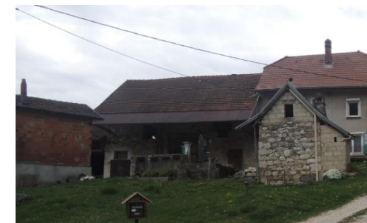
Débords de toiture important soutenus par des consoles en bois
