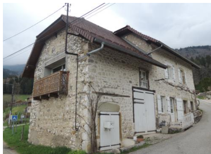
Façades en pierres calcaires, du pays, ou enduit (parfois avec chainage)
