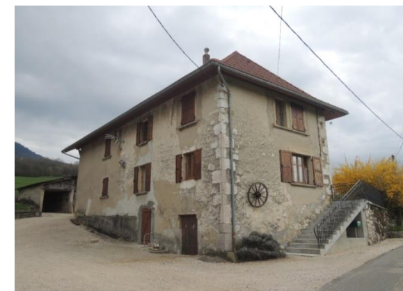
Débords de toiture plein,
