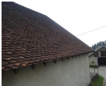
Variété des couvertures : Tuiles écaillés, mécaniques, lauze, tôle, ...
