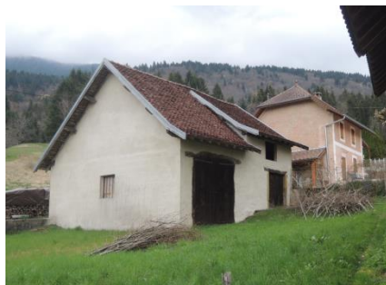
Façades en pierres calcaires, du pays, ou enduit (parfois avec chainage)
